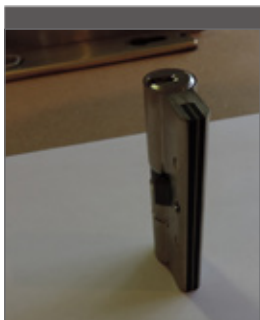
Een veiligheidscilinder is moeilijker te breken of te doorboren.
