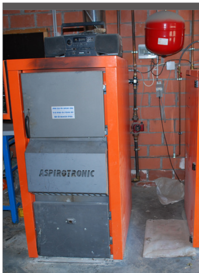
De pelletbrander heeft een voorraad van 60 kg pellets.
