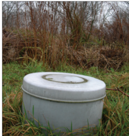
Controle van de kwaliteit van het afvalwater gebeurt via een meetput.
