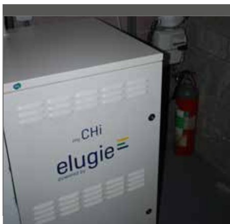
Waterstof uit gas wordt zonder verbranding omgezet in elektriciteit.
