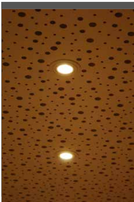
Geluid absorberen is mogelijk met een geperforeerd plafond, wandpanelen of baffels.
