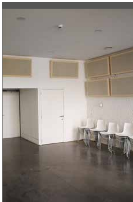
Geluid absorberen is mogelijk met een geperforeerd plafond, wandpanelen of baffels.
