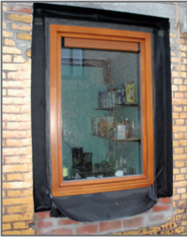
Links, rechts, boven en onder het raam zijn gevelstenen verwijderd om een luchtdichte afdichting tussen raamkader en muur mogelijk te maken. Daarna wordt er isolatie en crêpy geplaatst. Op die manier worden onaanvaardbare bouwknopen weggewerkt.
