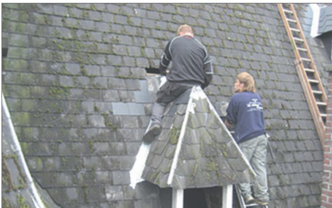
Asbest verwijderen doe je heel voorzichtig.
