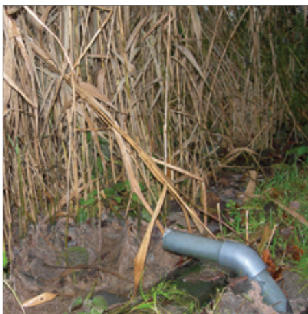
Het afvalwater wordt geloosd in het rietveld.
