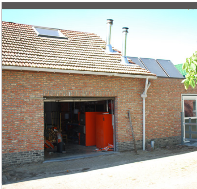
We maken gebruik van zonnecollectoren.
