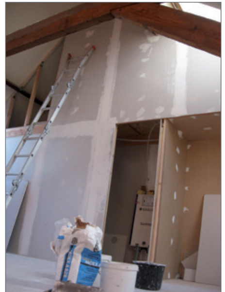
Verluchten is de boodschap tijdens het bouwproces.
