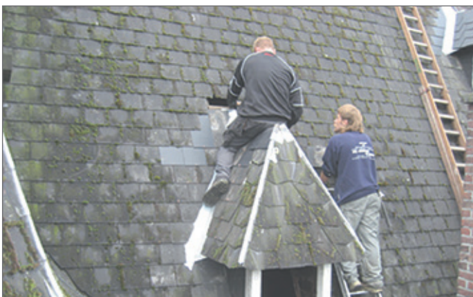
Asbest verwijderen doe je heel voorzichtig.
