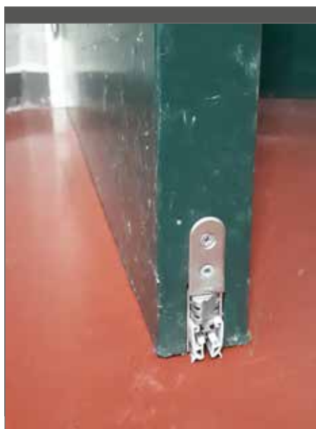
Dankzij een guillotinevoeg verbetert de geluidsisolatie bij deuren.
