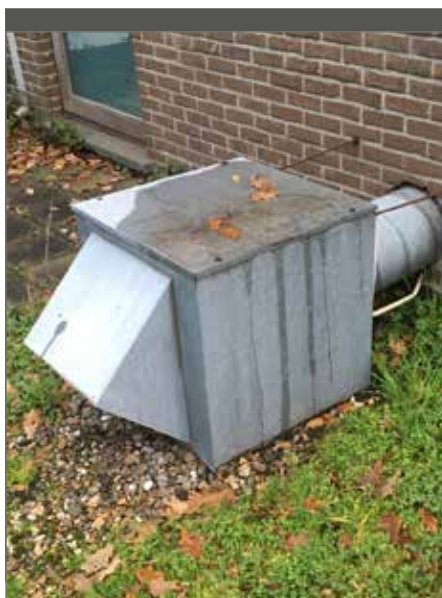
Door de motor van de dampkap op het dak te plaatsen, wordt installatiegeluid in de keuken vermeden.
