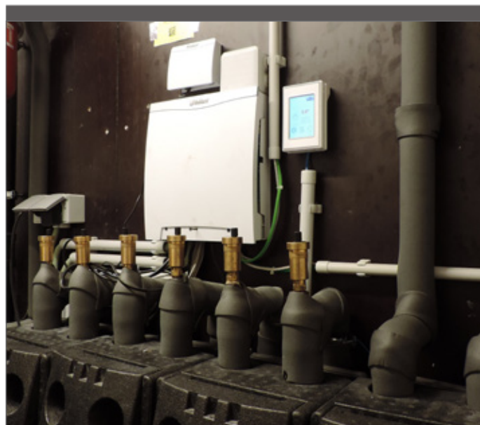
Drie circuits voor de centrale verwarming, één circuit voor het warm water.
